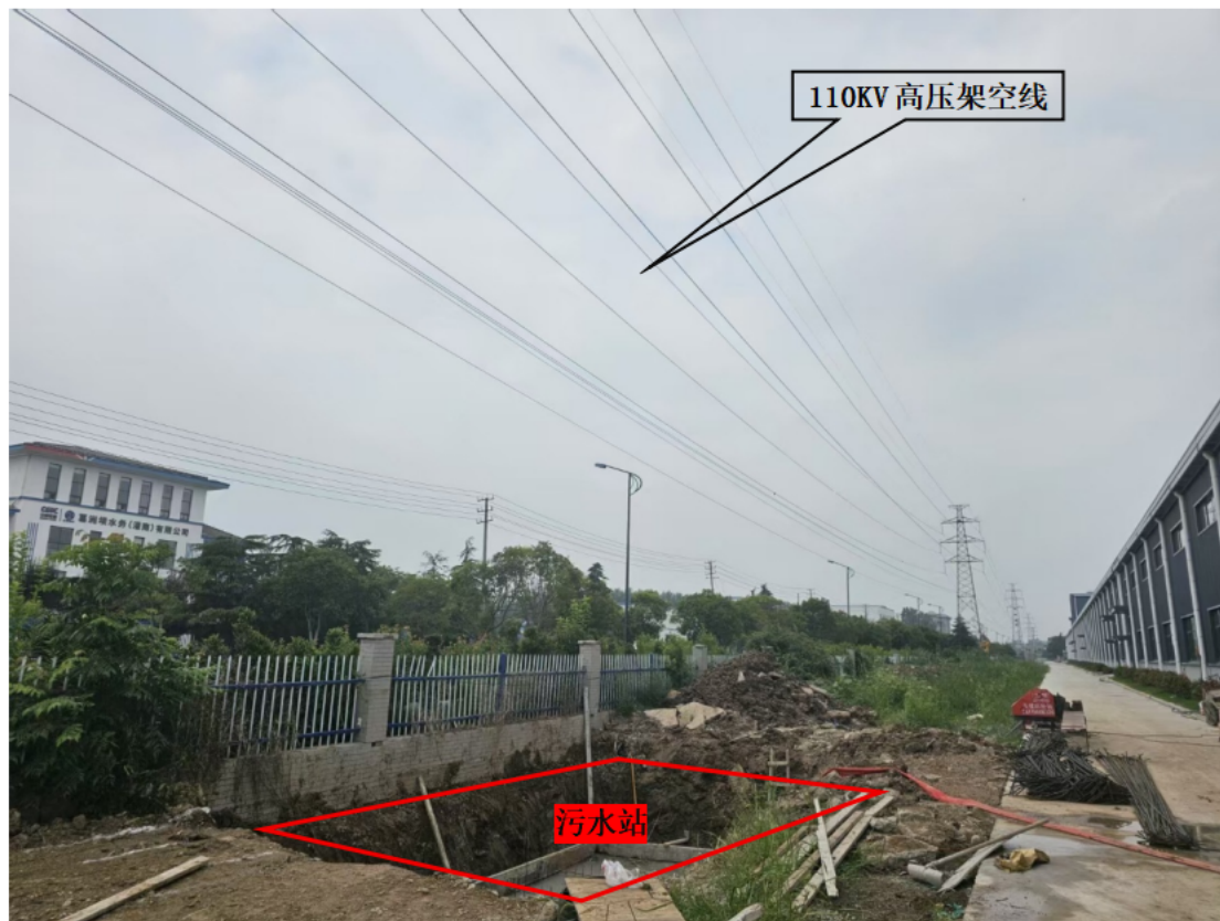
图 1.6-3 污水站和 110KV 高压架空线位置关系照片
